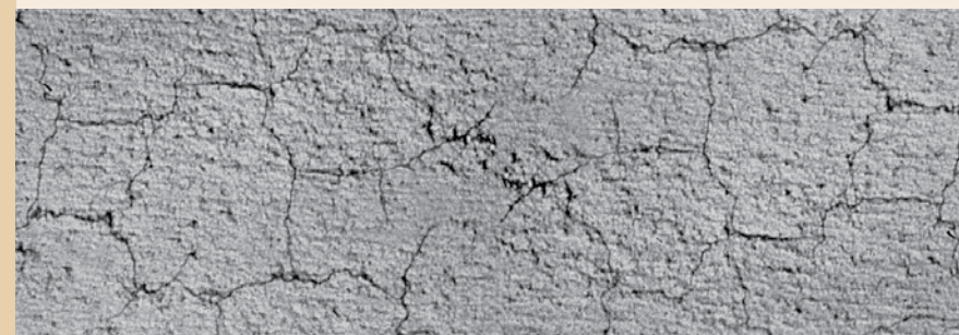
микротрещины/сетчатые трещины
