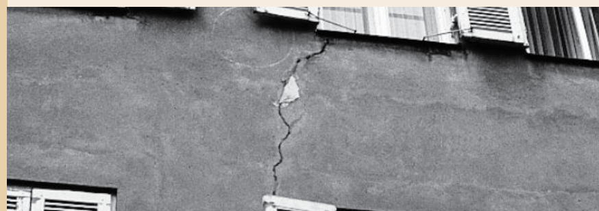
Строительно-динамические трещины
