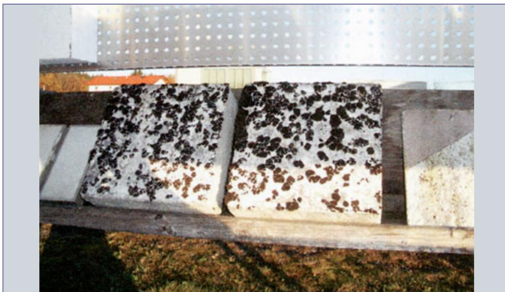
Рисунок 6. Экспериментальный фрагмент теплоизоляционного фасада, установленный с отклонением от вертикали примерно на 30°, ориентированный на запад, через 12 лет после установки. Значительно более высокое воздействие выпадающих осадков вследствие наклона поверхности привело к полному разрушению поверхностного слоя штукатурки и, как следствие, к сильному разрастанию мха на поверхности фасада.
