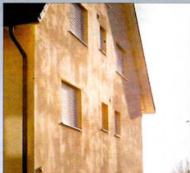
Условия ниже точки росы и увлажнение фасада за счет утренней росы явились основными предпосылками для возникновения растительного и грибкового налета
