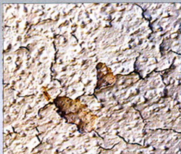
Дефекты возникли на минеральной декоративной штукатурке из-за несоблюдения режима высыхания поверхности после промывки фасада с использованием агрегатов высокого давления
