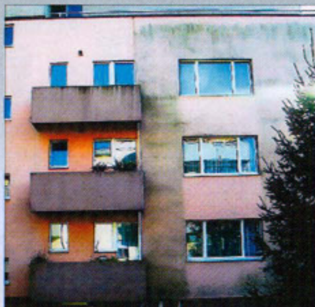
Растительный налет на всех холодных поверхностях декоративного покрытия фасада: левая часть объекта (с балконами) — с теплоизоляцией, правая часть объекта (без балконов) — без теплоизоляционной системы
