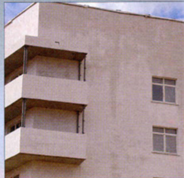
Намокание поверхностей теплоизоляционной системы фасада из-за неправильно организованного укрытия парапета и протечек
