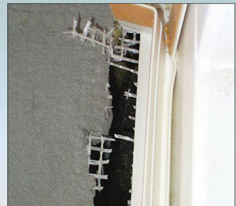
Деформационный профиль установлен с перекосом. Стеклотканевая сетка не заведена в полочку профиля. Зазор не заполнен теплоизоляционным материалом
