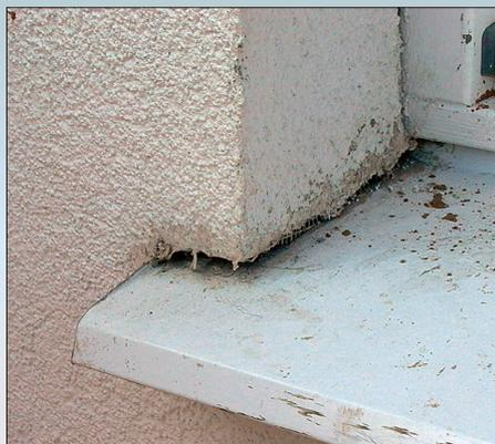
Отслоения, растрескивания и разрушения армирующего и декоративного слоев в местах примыкания к отливу появились из-за неправильно организованного деформационного шва
